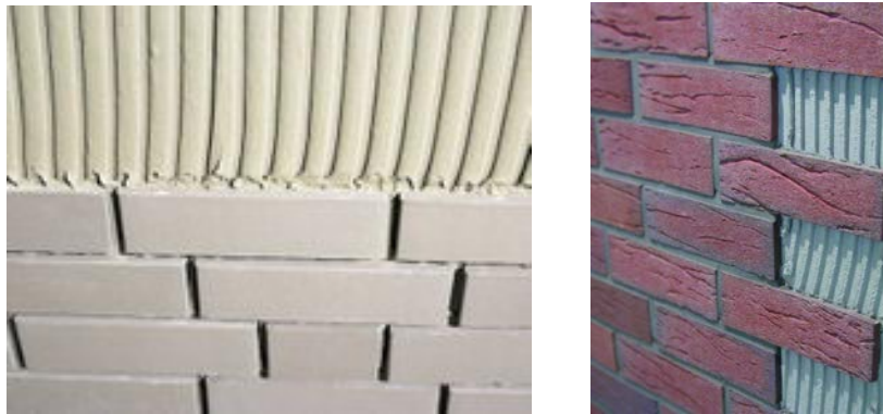
Рис.3 Плитка, уложенная на клей.
