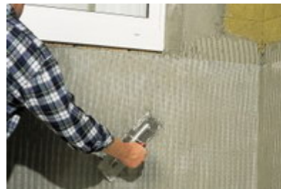
Укладка армированной сетки из штапельного стеклянного волокна
