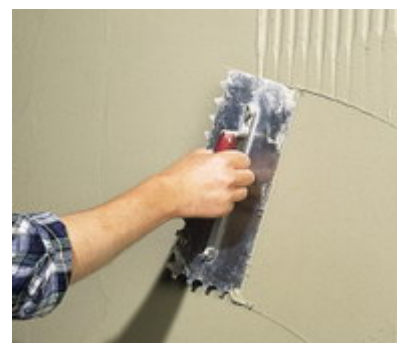
Рис.14 Нанесение и разглаживание второго слоя раствора
