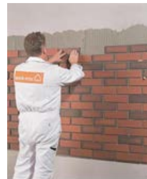
Рис.2 Разметка рядов с помощью шнура и приклеивание рядовой плитки
