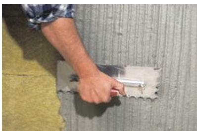
Нанесение раствора мастерком
