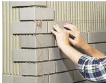
Рис.2 Разметка рядов с помощью шнура и приклеивание рядовой плитки
