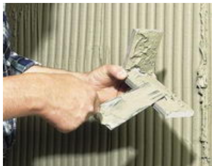
Рис.1 Нанесение клея на угловой элемент.
