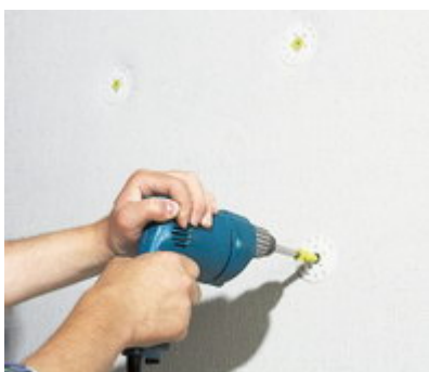
Рис.13 Вставка дюбелей на заранее измеренное расстояние
